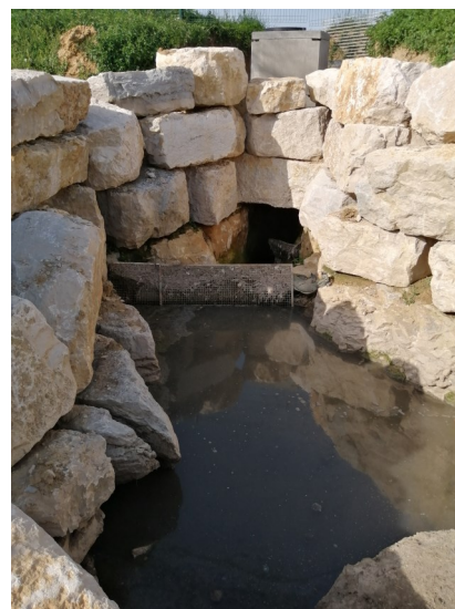
Enrochement, dessableur et sécurisation de la faille à la STEP de Pouligney
