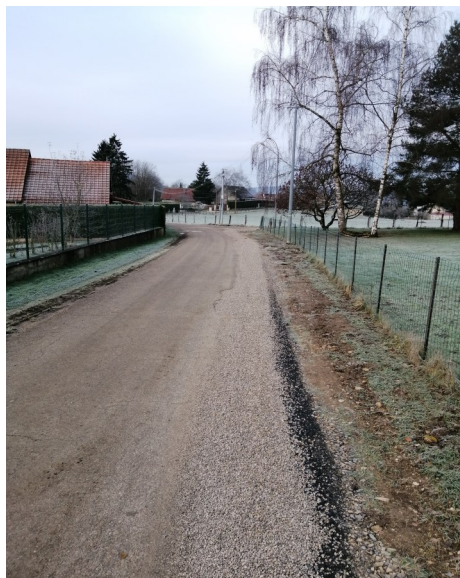
Travaux réseaux eau potable rue de la Chaille
