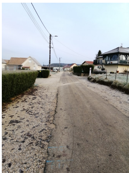
Travaux réseaux d'assainissement rue de la Pérousotte
