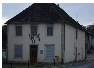
Mairie de Lusans (1839) avec 1 logement
