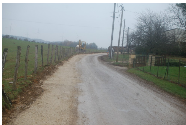
Rue du Charmey (eau et assainissement)
