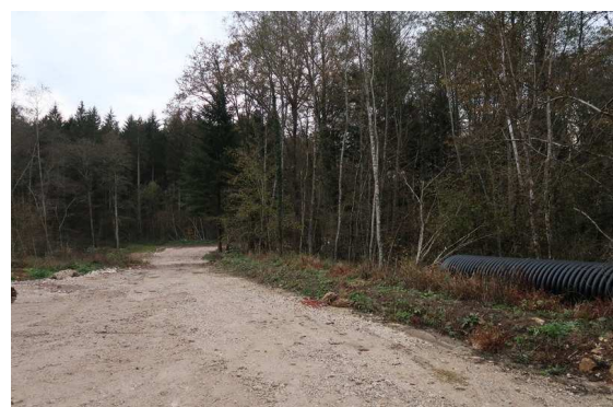
Chemin d'accès salle multi-activités
