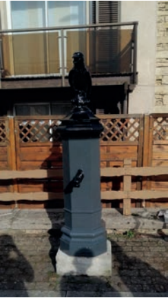
Nettoyage et peinture du corbeau à Pouligny
