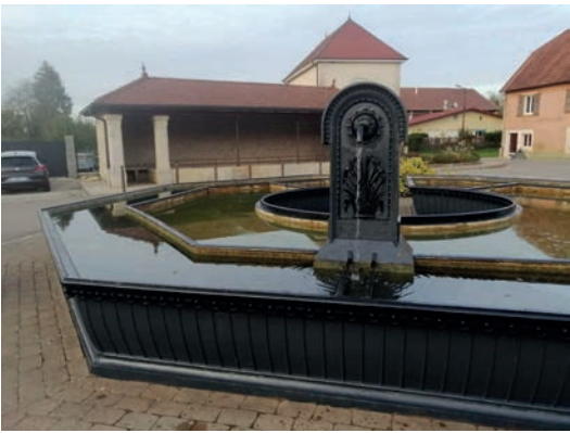
Nettoyage et peinture de la fontaine à Pouligny
