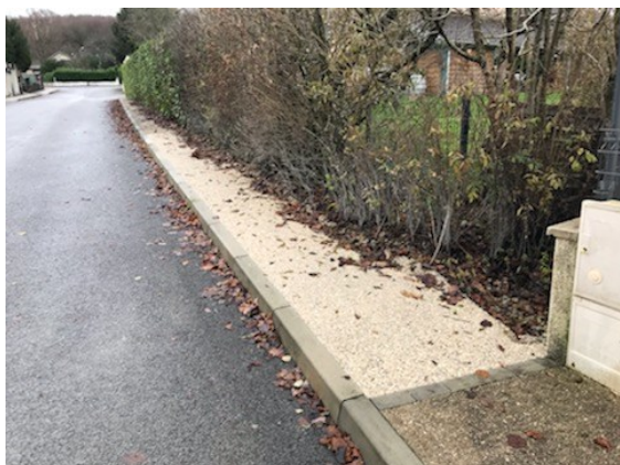
Trottoirs rue du Verjoulot
