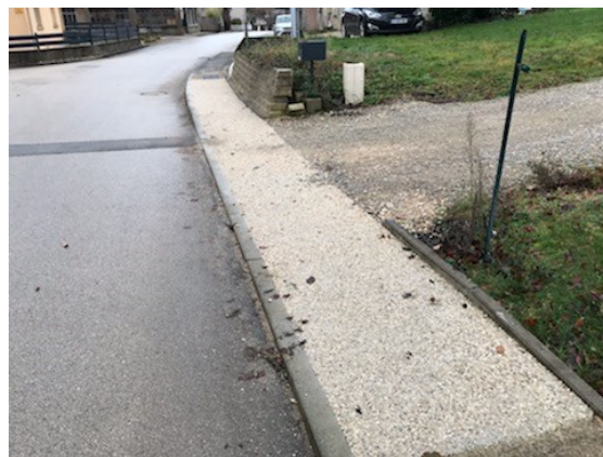
Trottoirs rue d'Archamp
